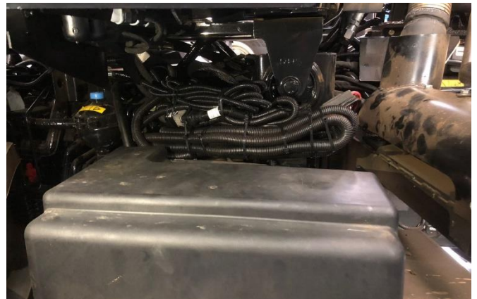
Figura 15 – Arneses fijados sobre la caja de batería
