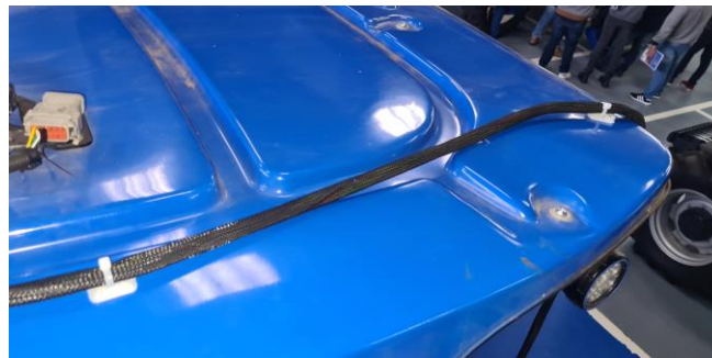
Figura 19 - Fijación del arnés de RS1 al techo de la cabina
