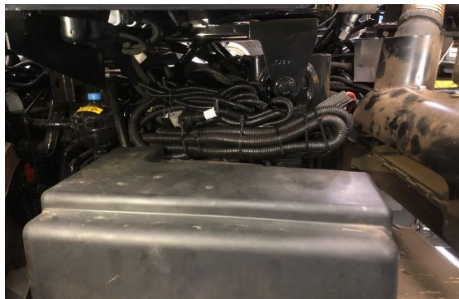
Figura 15 – Chicotes fixados acima da caixa de bateria
