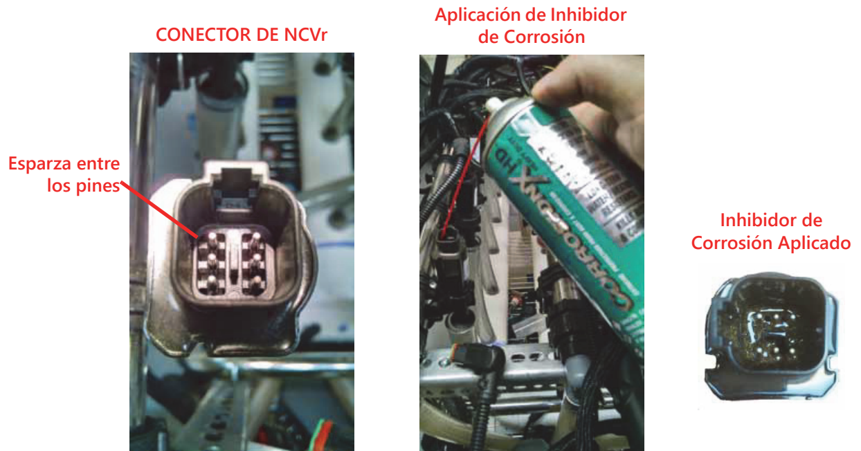
FIGURA 4. Cómo aplicar CorrosionX tras la limpieza
