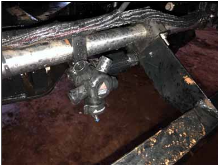
FIGURA 4. Fixando as ramificações do cabo
