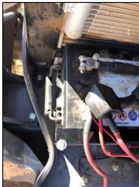
FIGURA 3. Cabos POWER do Chassis e do Hawkeye Conectados à Bateria
