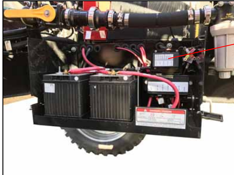
FIGURA 4. Panel de fusibles
