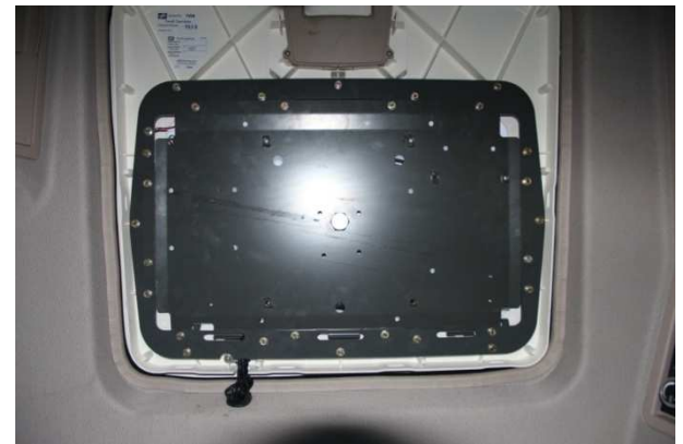
Figuur 12 Bekleding verwijderd
