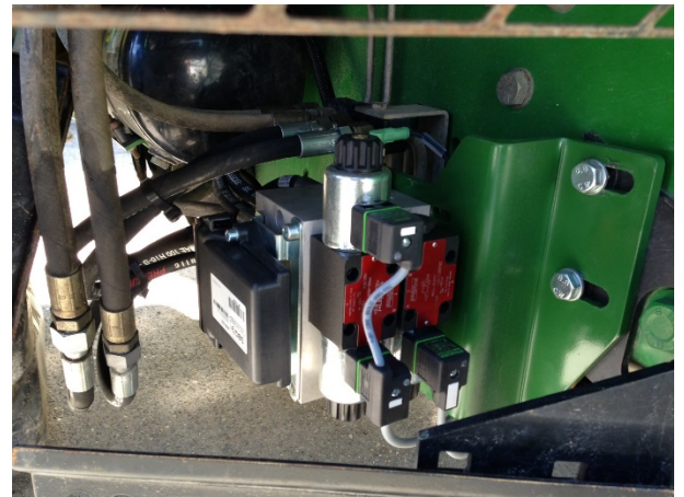
Figuur 2 Montage manifold en steering controller.
