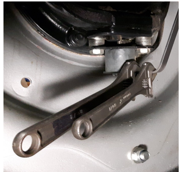
Figuur 30 Strip bijbuigen met behulp van Bahco's.
